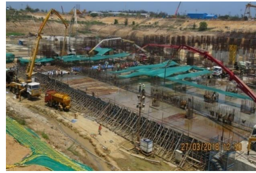
Figure 1 (b). Mega pour @location
